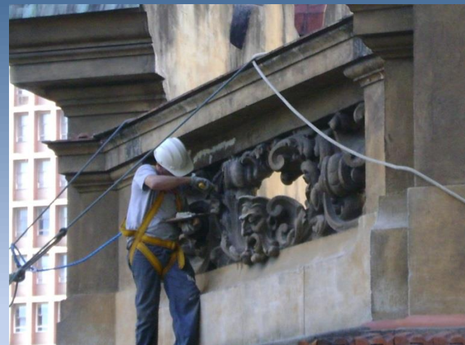
intervenção emergencial em julho de 2011. Fonte: Arquivo IPHAN RJ
